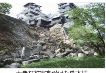
大きな被害を受けた熊本城(熊本市ホームページより)
