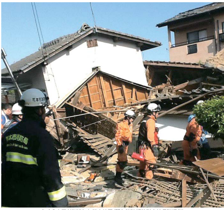
多くの家屋が倒壊した熊本地震(緊急消防援助隊宮崎県隊提供)
