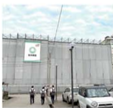
来月の完成に向けて工事が進む新校舎棟(C棟)
