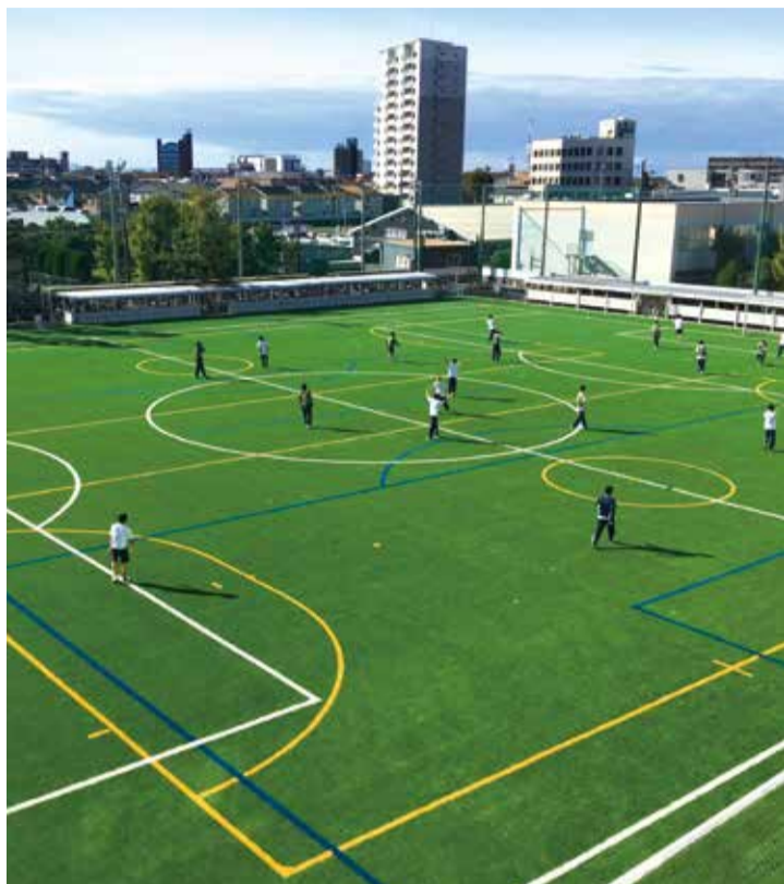
完成した人工芝グラウンド
