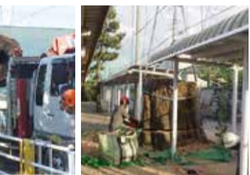
クレーンを使った吊り切り
