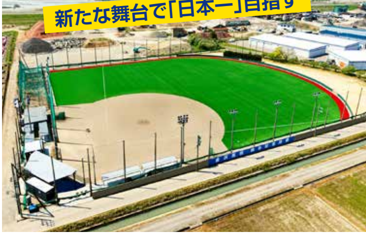
改修工事が完成した駒谷記念球場
